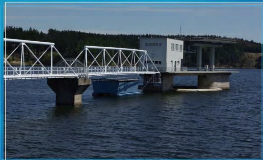
Úpravna Želivka - odběrný objekt
